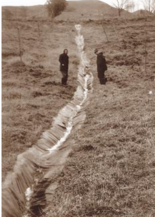
Butyl rubber flume. Photo: Gisborne DC.
